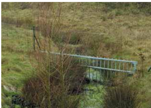
Grille laissant un vison d'Europe pénétrer dans l'infrastructure
