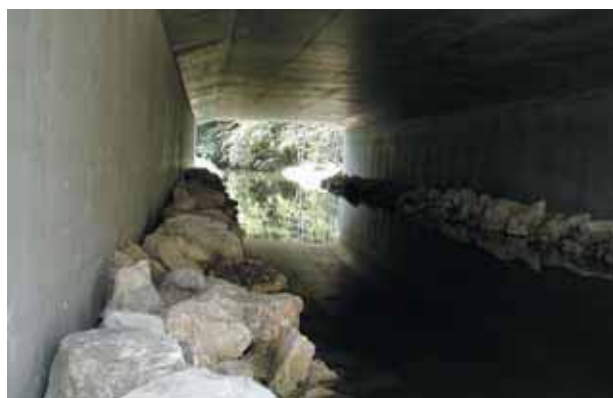
Banquette en construction
