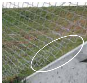
Défaut de raccordement à l'ouvrage hydraulique
