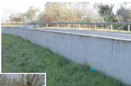
Glissière en béton armé en bord de chaussée
