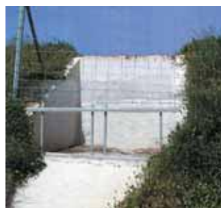
Surverse d'un bassin de traitement des eaux de plateforme
