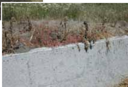
Paroi côté chaussée d'un fossé collecteur des eaux de plateforme
